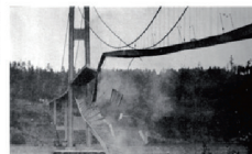
Obr. 9 Postupnosť zničenia mosta vytvorená z fotografie na mieste (príprava animácie)
