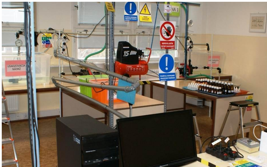
zložitý potrubný systém modelu úpravné vody, vytvorený v rámci projektu Krimichémia, kde hodnota súčiniteľa prestupu tepla je dôležitým ukazovateľom procesu
