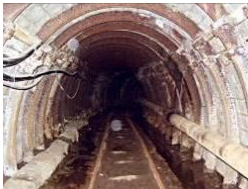
Obrázok 111: Hlavná prístupová chodba k ložisku suroviny s výstužou a koľajnicami Prameň: vlastný archív
