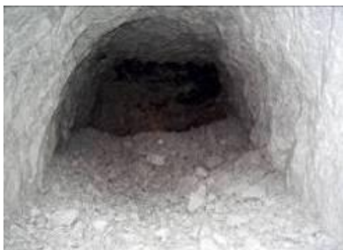
Obrázok 122: Vyrazené horizontálne banské dielo po odstrele (čelná časť po odstrele)
